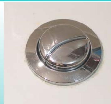
Pulsador de doble tecla: la tecla grande descarga parcialmente la cisterna, mientras que la pequeña produce la descarga completa.
